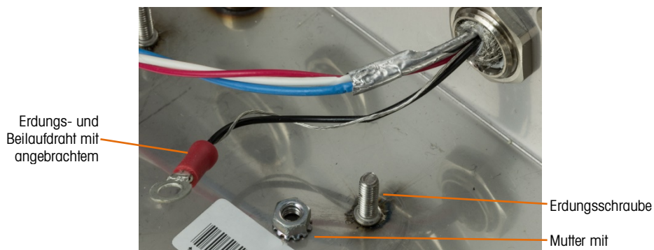
Abbildung 2-73: Vorbereitung der Erdungsdrähte des PowerMount-Kabels
