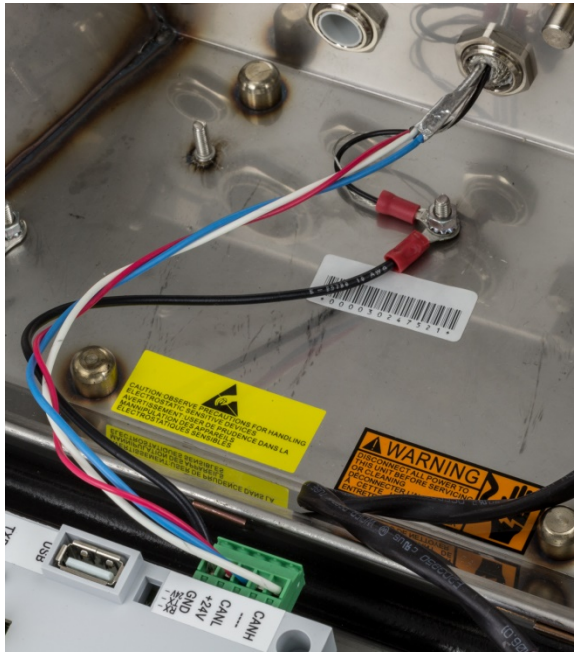
Abbildung 2-77: Abgeschlossene Installation des PowerMount-Kabels im Gehäuse für raue Umgebungen
